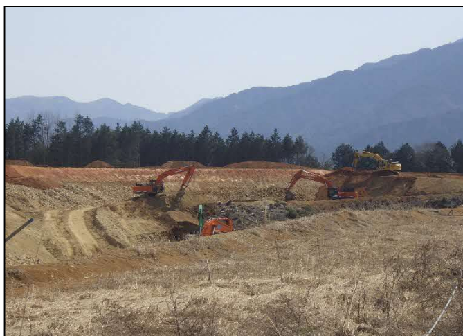
写真 車両基地エリア
