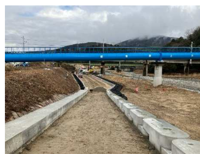
写真-1 落合川河川敷施工状況
