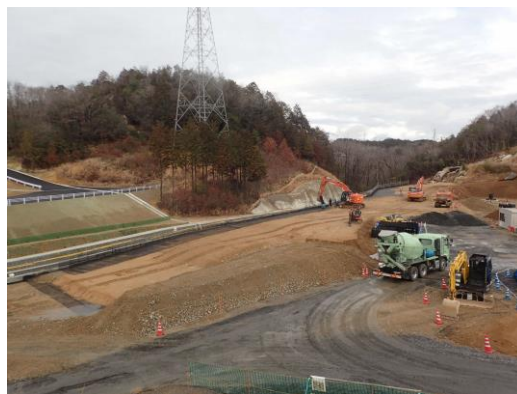
写真 擁壁工（施工状況）
