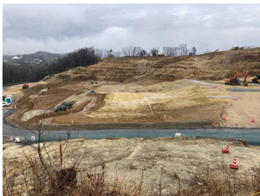
写真 盛土工（施工状況）
