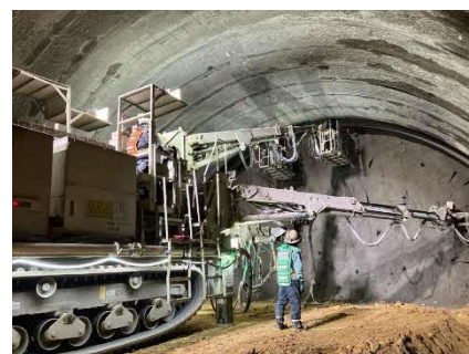
写真 トンネル施工状況
