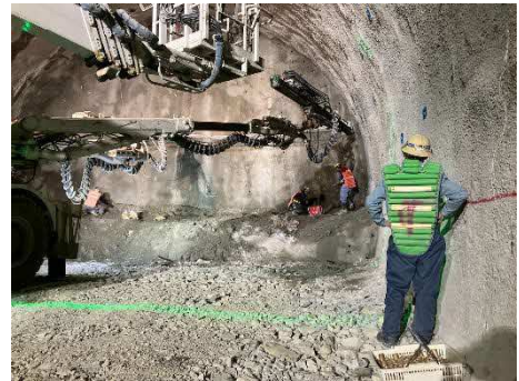
写真-1 装薬状況
