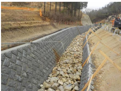
写真 河川付替え状況
