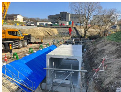
写真 ボックスカルバート施工状況
