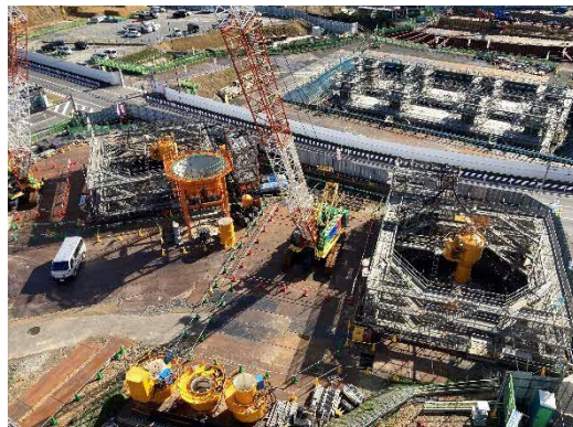
写真 ニューマチックケーソン基礎工事 施工状況
