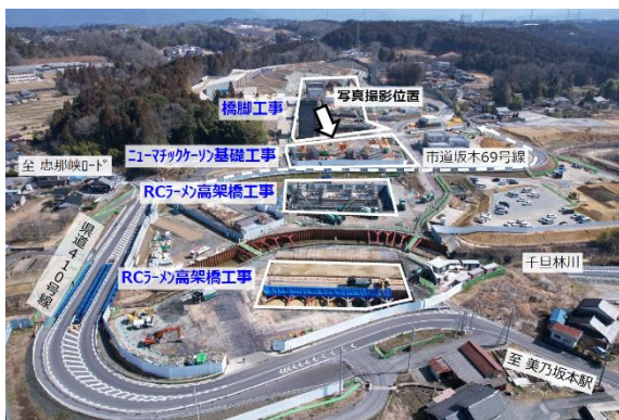
図 当月の主な工事範囲（駅東部）
