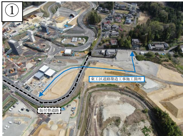
【状況写真 R6.4月時点】
