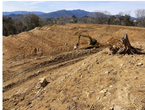
写真 伐採状況
