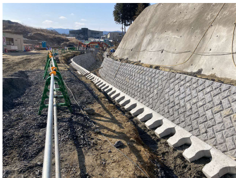
写真 河川付替え状況
