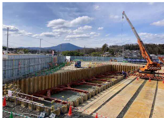
写真 RC ラーメン高架橋工事 掘削状況
