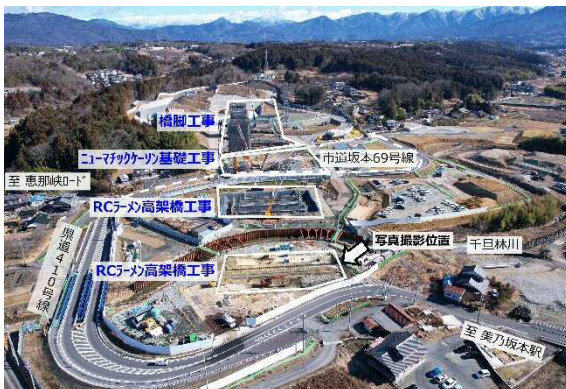
図 当月の主な工事範囲（駅東部）
