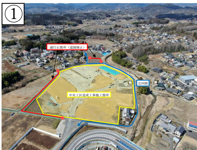
【状況写真 R6.3月時点】
