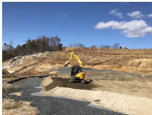
写真 盛土状況
