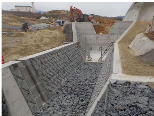
写真 河川付替え状況
