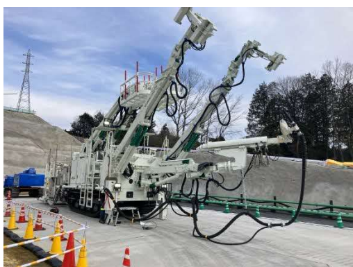
写真 トンネル使用機械
