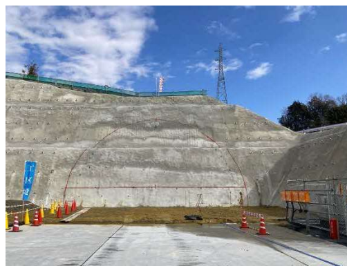
写真 トンネル坑口前
