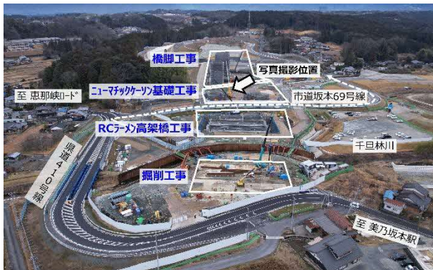
図 当月の主な工事範囲（駅東部）
