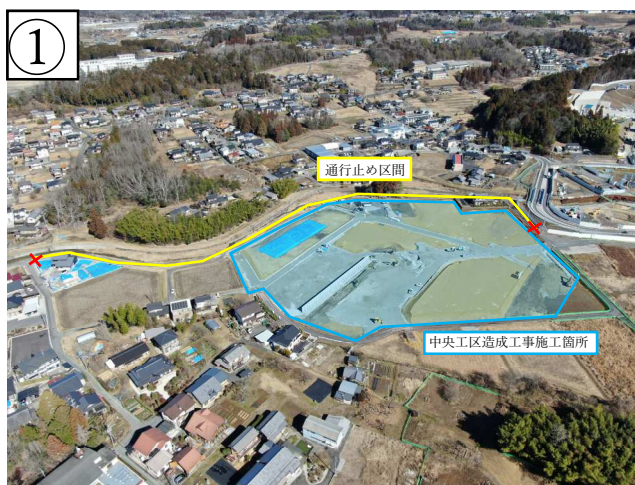
【状況写真 R6.2月時点】
