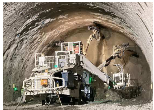
写真-1 穿孔状況
