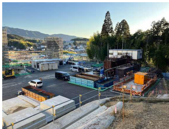
写真 トンネル設備設置状況
