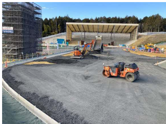
写真 ヤード舗装工事状況
