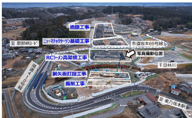
図 当月の主な工事範囲（駅東部）
