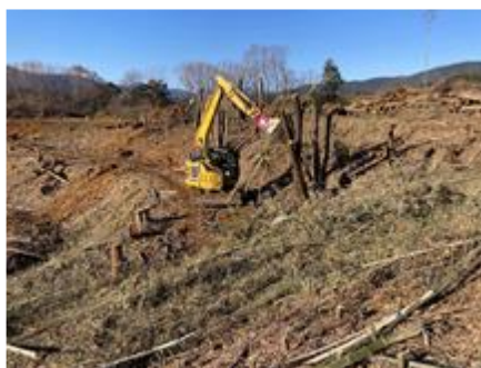
写真 ヤード北側伐採状況
