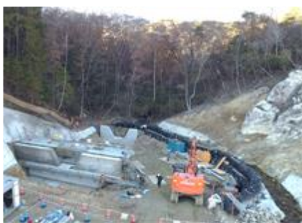
写真 付替河川施工状況
