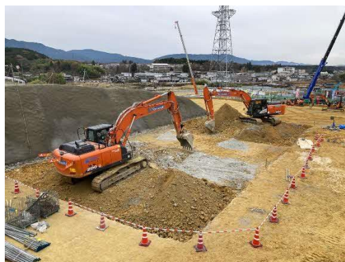
写真 路床改良施工状況
