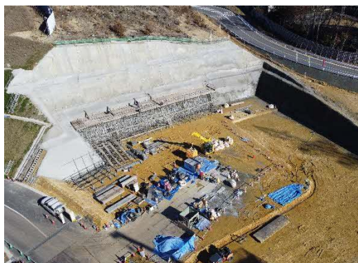
写真 坑口3段目 法面対策工施工状況
