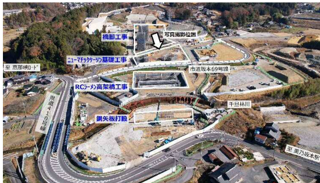
図 当月の主な工事範囲（駅東部）
