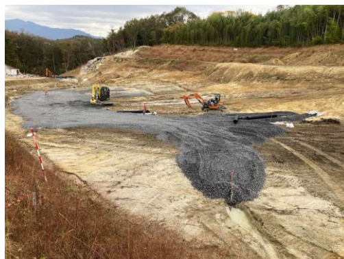
写真 暗渠排水施工状況
