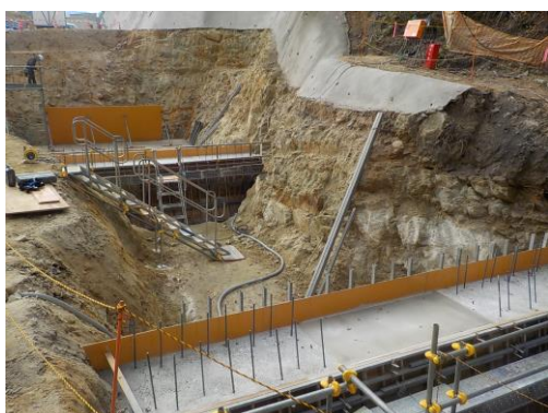
写真 付替河川施工状況
