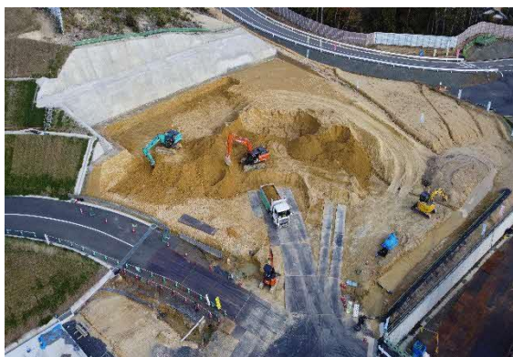
写真 坑口3段目 切土工施工状況
