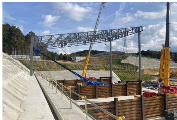
写真 発生土仮置場施工状況
