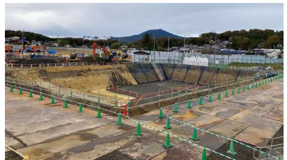
写真 RCラーメン高架橋工事 施工状況
