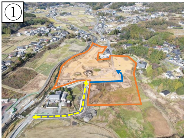
【状況写真R5.11月時点】
