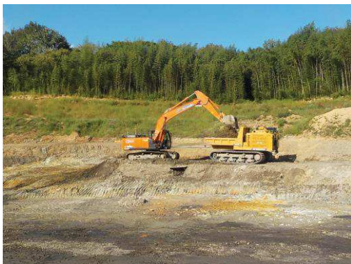
写真 表土処理工 (改良表土剥ぎ取り・積込状況)
