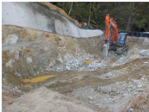
写真 付替河川掘削状況
