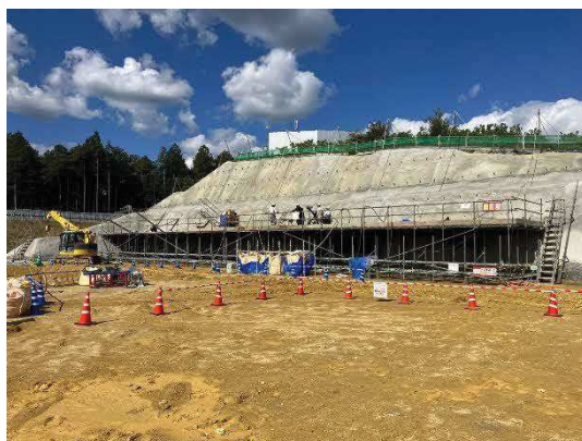
写真 坑口2段目 法面对策工施工状況
