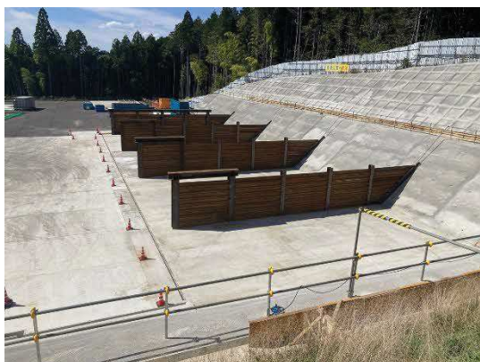
写真 トンネル発生土仮置場施工状況
