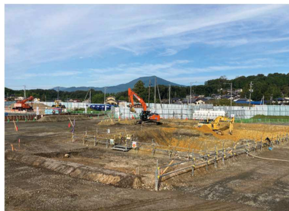
写真 RC ラーメン高架橋工事 施工状況
