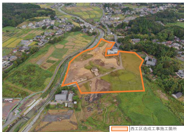
【状況写真 R5.9月時点】
