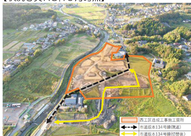
【状況写真 R5.10月時点】
