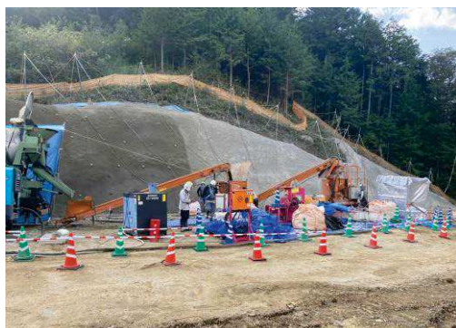
写真 法面对策工
