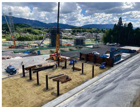
写真 発生土仮置場施工状況
