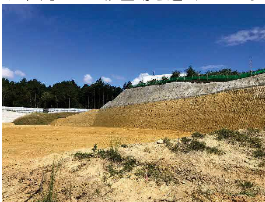
写真 坑口2段目掘削完了
