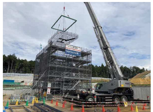
写真 橋脚工事 施工状況
