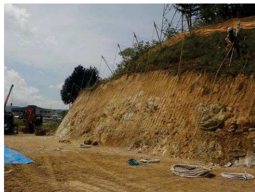
写真 法面对策工
