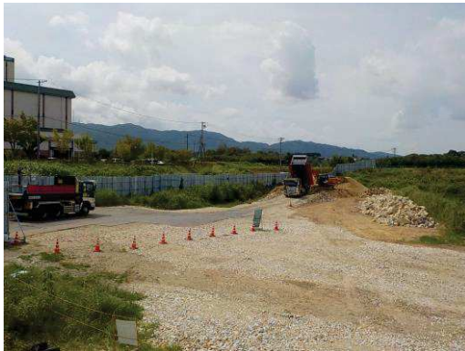
写真 発生土受入状況
