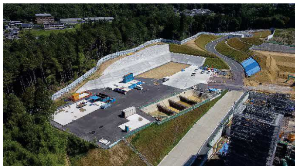
写真 ヤード造成状況
