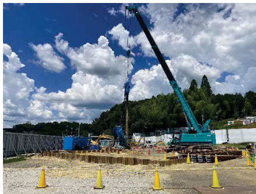
写真 ヤード造成工事 施工状況
