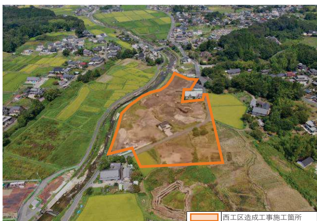
【状況写真 R5.8月時点】
