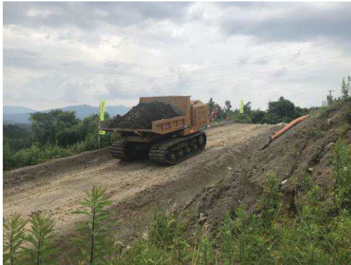
写真 表土運搬状況
