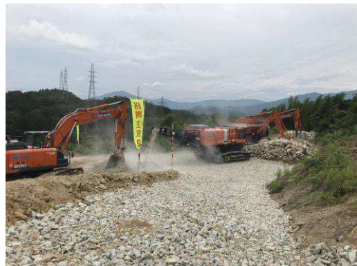
写真 支障物撤去状況
