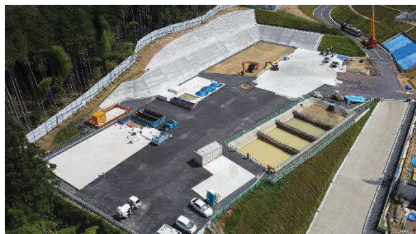
写真 ヤード造成状況
