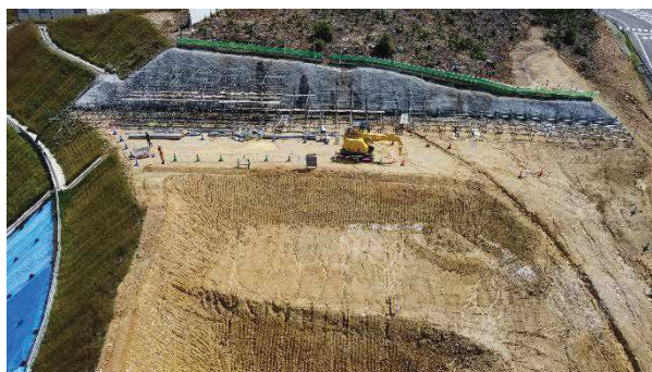
写真 坑口付近法面補強状況
