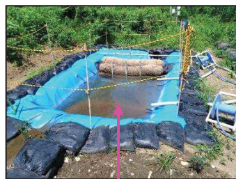
ちんさち 沈砂池（仮設） ※排水に含まれる砂を除去するための池
