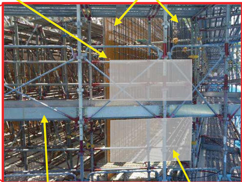
足場 ※手が届かない場所の作業をするための足場
