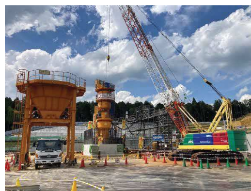
写真 橋脚基礎工事 施工状況
