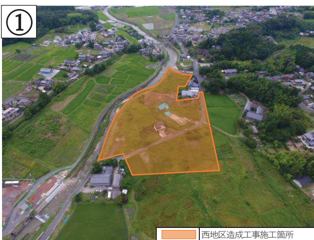
【状況写真 R5.7月時点】
