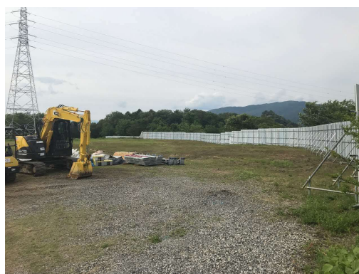
写真 仮囲い設置状況
