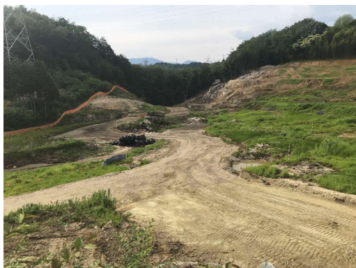
写真 工事用道路状況
