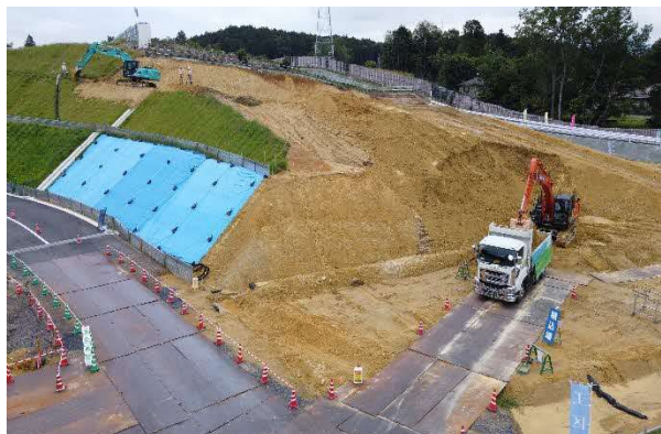
写真 坑口付近掘削状況
