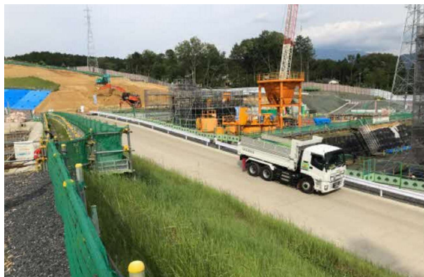
写真 掘削土運搬状況
