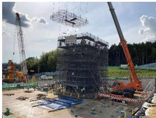
写真 橋脚工事 施工状況
