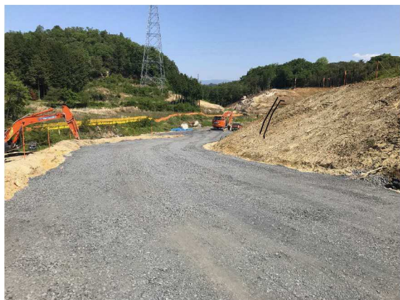
写真 工事用道路状況 【工事工程】
