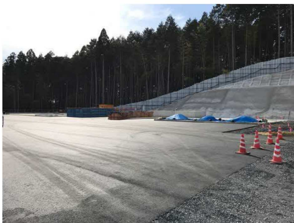
写真 ヤード舗装状況
