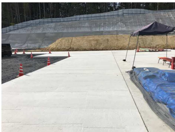
写真 ヤード舗装状況
