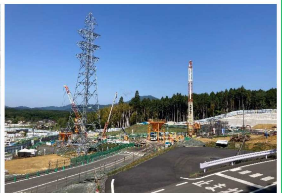
写真 橋脚基礎工事、橋脚工事 施工状況
