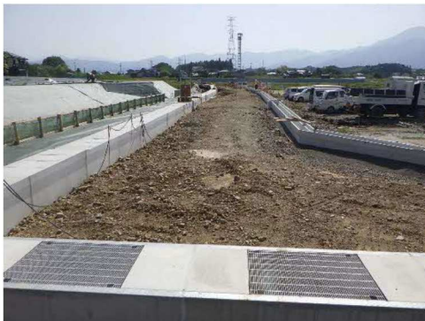
付替水路道路工事状況
