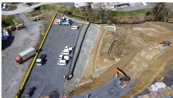
写真 工事用道路状況
