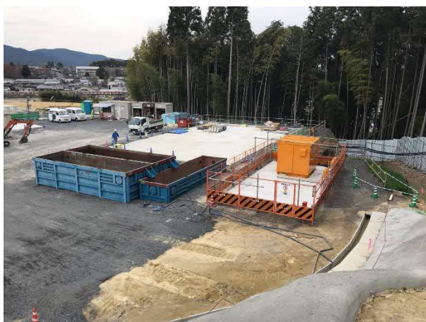
写真 基礎工状況
