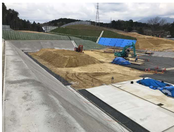
写真 ヤード舗装状況
